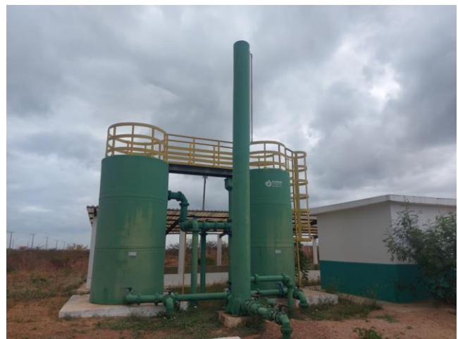
Figura 8- Filtros (Asc e Desc)
