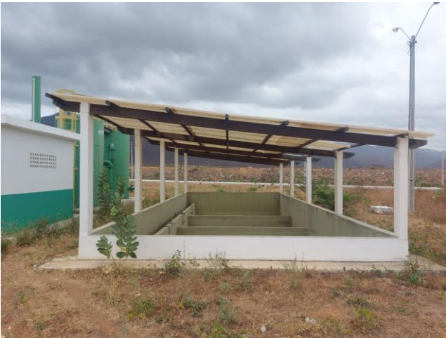
Figura 9- Leito de Secagem (Biológico)
