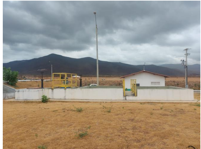
Figura 4- Mistura lenta e decantador
