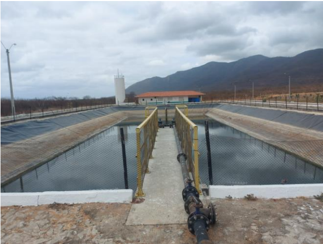
Figura 3- Lagoa Anaeróbia
