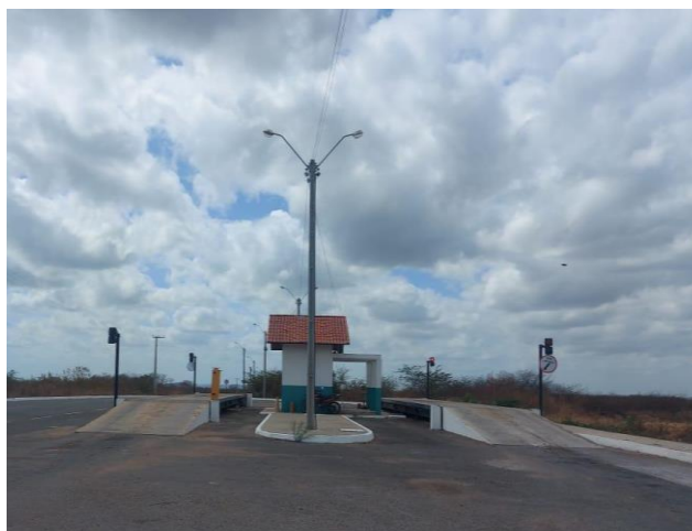
Figura 14- Balanças Rodoviárias e Casa de Controle
